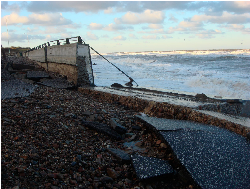
Stormen Bodil, december 2013, underminerede den hårde kystbeskyttelse.
